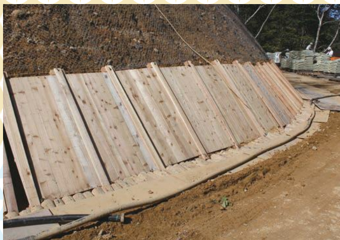
左上：治山事業施工地の裸地（2024年4月）、右上：挿したヤナギが定着し、順調に生育している様子（2024年8月） 左下：法面保護用木製パネル：設置時（2016年10月）、右下：法面保護用木製パネル：約7年半経過時（2024年5月）
