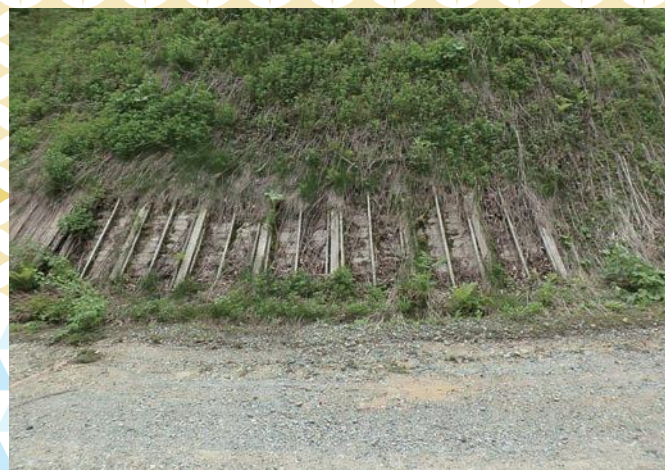
左上：治山事業施工地の裸地（2024年4月）、右上：挿したヤナギが定着し、順調に生育している様子（2024年8月） 左下：法面保護用木製パネル：設置時（2016年10月）、右下：法面保護用木製パネル：約7年半経過時（2024年5月）
