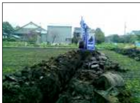
バックホーによる鋤床層の破碎
