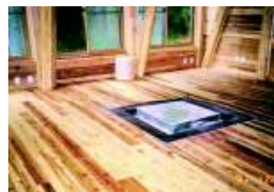
写真 有峰ハウスの施工例
