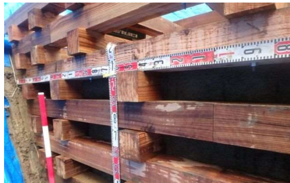
図6 現地での組み立て状況
