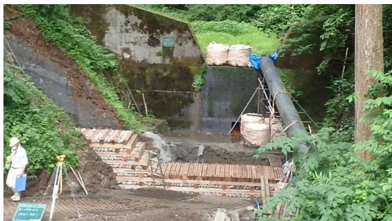
図7 既存コンクリート製ダムの下流側の洗掘を防ぐことを目的に設置した木製ダム
