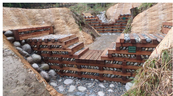
図8 上下流に2基連続して木製ダムを配置して荒廃溪流を安定化
