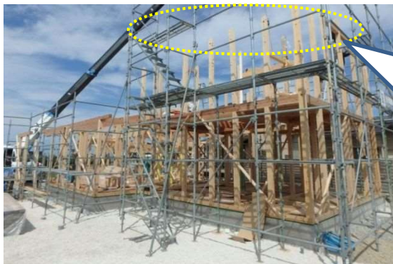
図6 芯去り平角材の利用例（建設中の住宅 2020.10 魚津市内、登り梁を設置する前）
