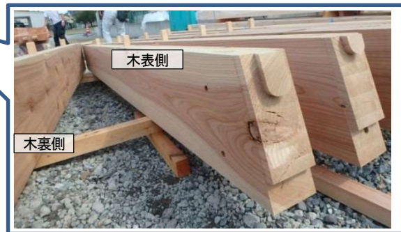
図6 芯去り平角材の利用例（建設中の住宅 2020.10 魚津市内、登り梁を設置する前）
