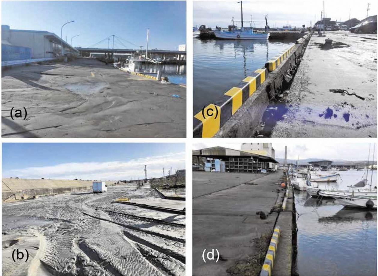
図1 能登半島地震による富山県での漁港の被害状況。(a) 岸壁エプロンの沈下(新湊漁港東地区)、(b) 液状化による臨港道路の噴砂(新湊漁港東地区)、(c) 物揚場の傾倒・沈下(新湊漁港西地区)、(d) 物揚場の傾倒・沈下(氷見漁港)。
