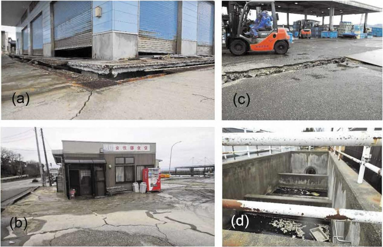
図2 能登半島地震による富山県での共同利用施設の被害状況。(a) 荷捌き所基礎の陥没(とやま市漁協水橋支所), (b) 液状化で傾倒した女性部食堂(新湊漁協), (c) 荷捌き所の段差(氷見漁協), (d) 傾倒した陸上養殖場の排水樹(堀岡養殖漁協)。
