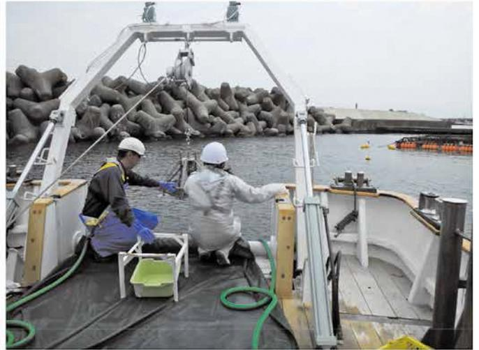
図4 採泥器による採泥作業
