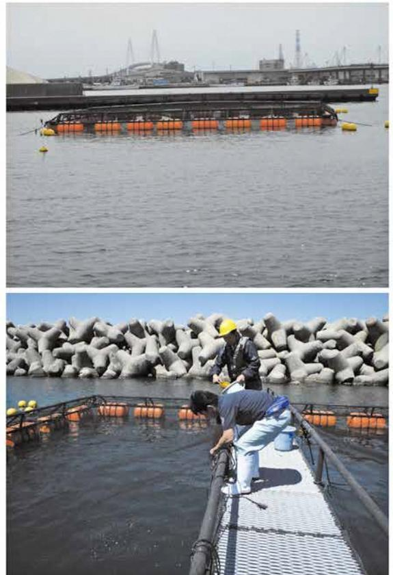
ほぼ中央で、漁船の航行の安全性を考慮して、北側に位置する防波堤にできるだけ近づけた。なお、同防波堤はコンクリートブロックを積み重ねてできたものであり、生簀周辺には漁港の入り口だけでなく、北側の防波堤からも海水が浸透していた（図2）。
