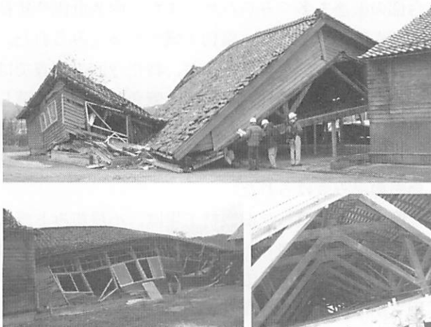
図-14 倒壊した旧製材工場（門前）
