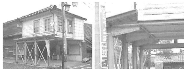
図-18 鉄骨造ピロティの建物（門前）
