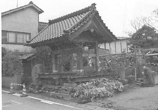
図-35 曳屋技術による釣鐘堂の復旧状況（門前）
