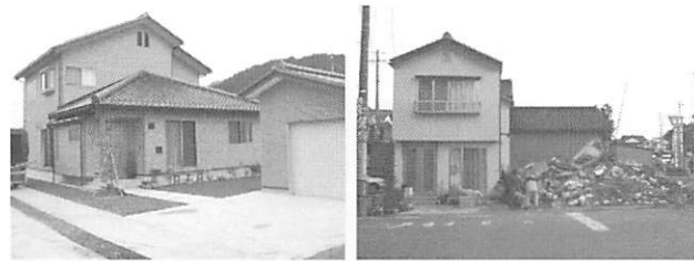
図-16 被害軽微な新しい建物（門前、穴水）
