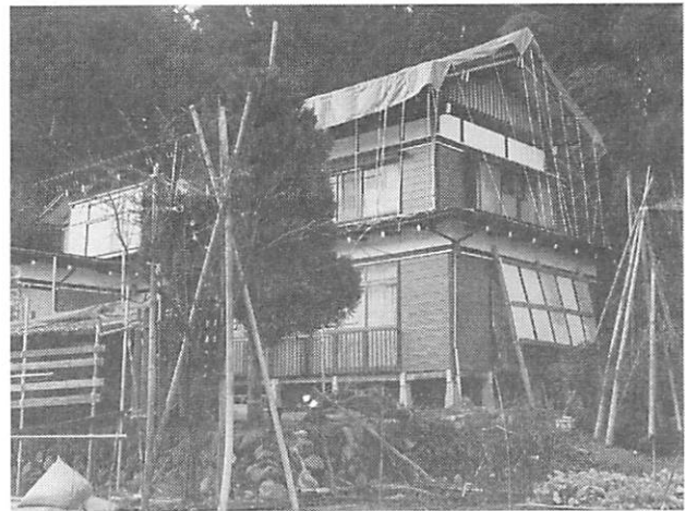
図41 束基礎の転倒防止措置（田麦山地区）
