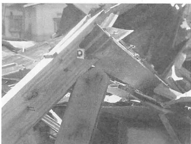
(c) 筋交いおよび柱-横架材接合部
