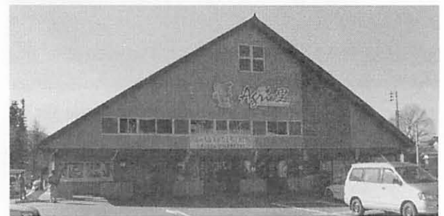
(a) 建物の外観
