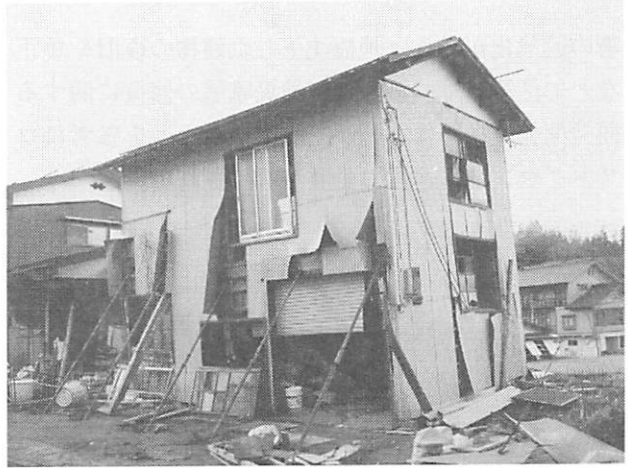
図40 金属棒によるひかえ（田麦山地区）
