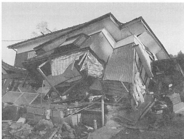
(a) 転倒した住宅の外観
