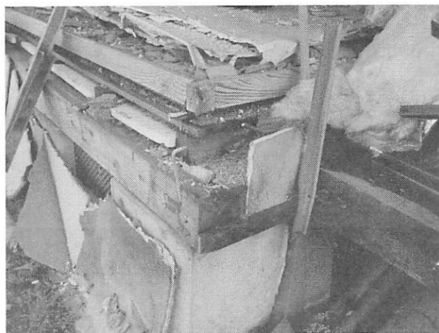
図21 無処理スギ土台の例 (田麦山地区)
