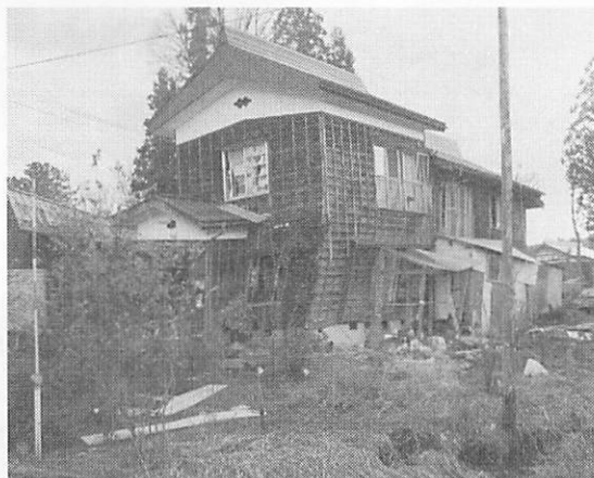
図12 残留変形の著しい家屋（田麦山地区）
