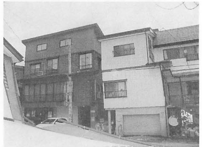
図18 構造計画の差異が耐震性に表れた隣接家屋 (川口地区、写真提供：中谷浩2004/11/21撮影)
