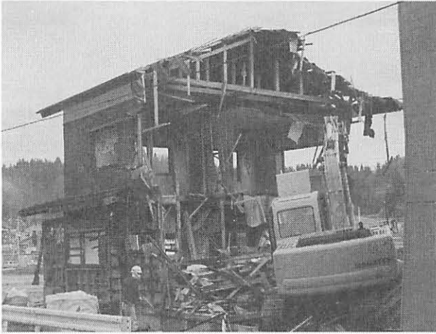
図42 解体中の家屋（田麦山地区）
