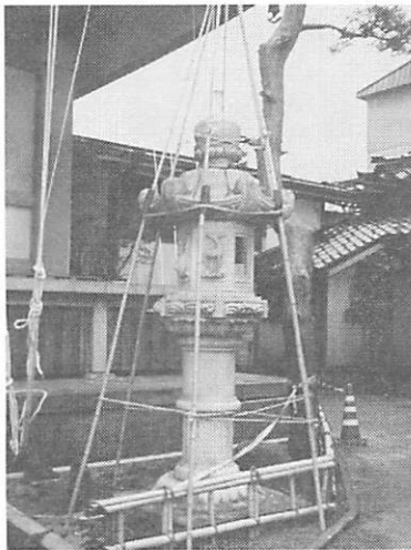
図39 石灯籠の転倒防止措置（長岡市）
