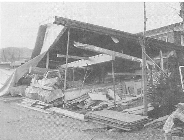
図16 木造作業小屋の倒壊(田麦山地区大形付近)
