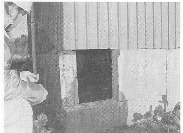
図24 無処理スギ土台の加害跡（田麦山地区）
