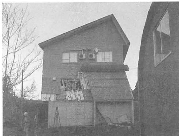
(a) 建物の外観
