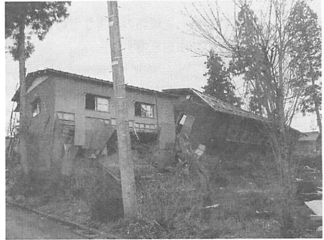
(a) 倒壊した作業小屋の外観
