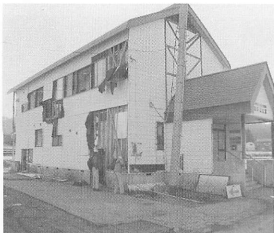
(a) 建物の外観
