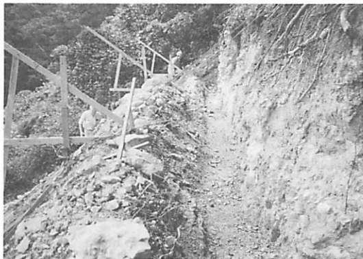
写真4 掘削状況 Foundation work.
