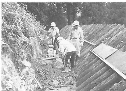
写真7 埋め戻し Backfill.
