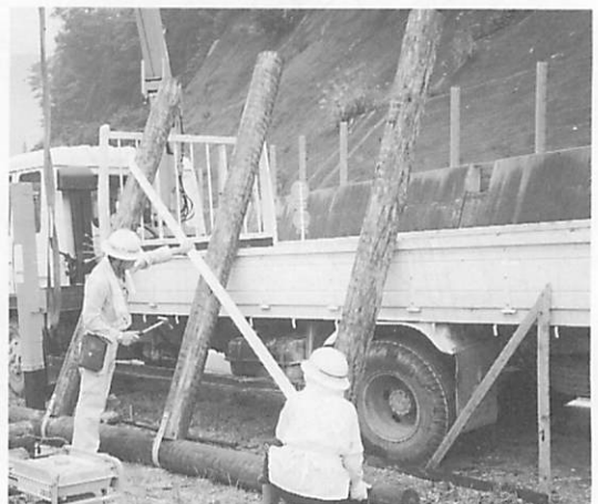
写真3 土場での組立て Fastening of stud and arm.
