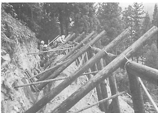
写真6 縦柵丸太の取り付け Fabrication.
