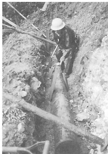
写真5 基礎丸太の固定 Base log fixed by steel angles.
