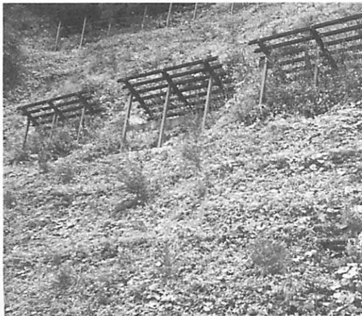
写真1 鋼製なだれ予防柵 Steel snow bridge.
