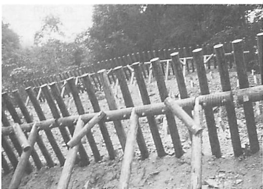
写真8 木製なだれ予防柵 Wooden snow rake.
