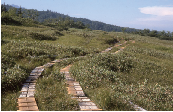
写真-7 初期の木道 枕木の直置きであった b地点のやや南側 1986年8月22日撮影 (加藤治好)
