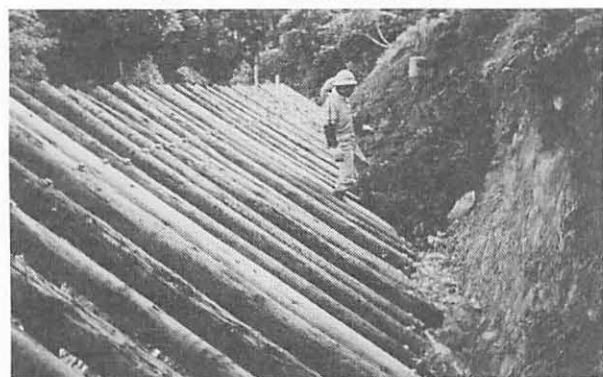
写真-4 縦柵脚部の埋め戻し作業(1989.9.21)
