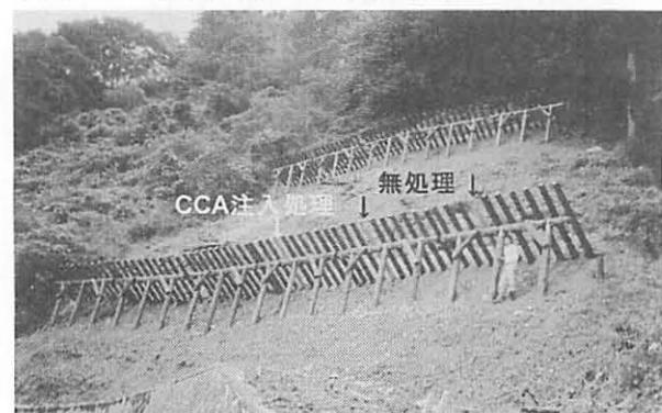
写真-5 雪崩予防柵完成直後の状態(1989.10.20)
