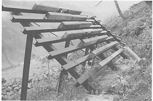
写真2 積雪荷重測定装置の設置状況
