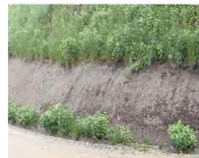
図6 県産スギ樹皮・モルタル吹付けによる防草施工
