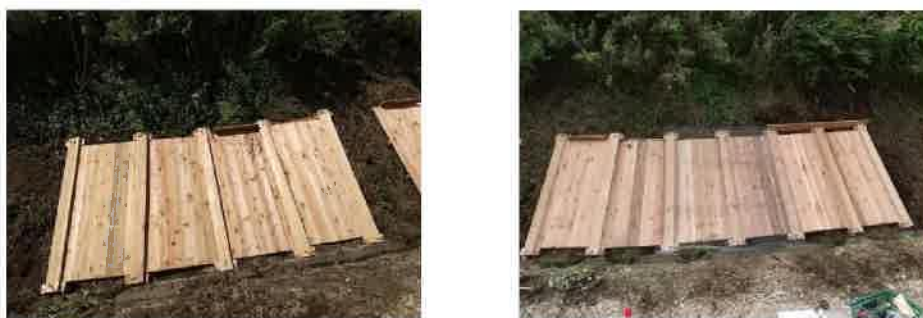
図5 改良型パネル 左：側溝隣接型と複合型 右：屋根型と金網型
