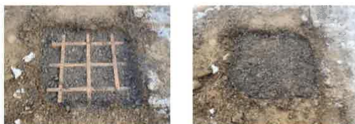
図 6 試験施工した木製格子路盤安定材（A 型＋碎石条件）
