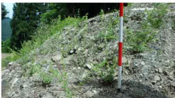
図 3 施工地でのヤナギ類挿し木の活着状況
