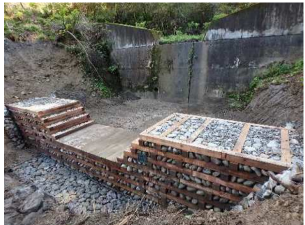
写真2 組み上がった木製床固工の状況
