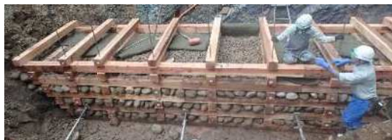
写真1 部材搬入状況 (上) と組立て状況 (下)
