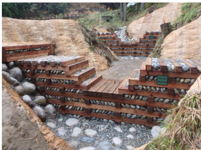
写真2 出来上がった木製床固工の状況
