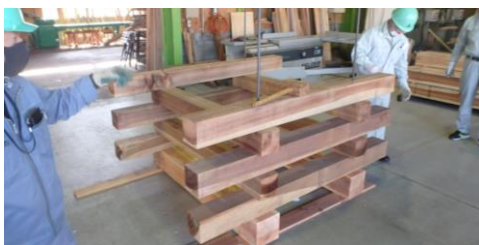
写真1 部材加工状況 (上) と仮組状況 (下)
