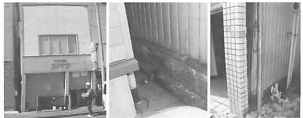
図8 店舗併用住宅の被害(柏崎市東本町)
