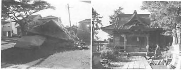
ア) 本殿の倒壊 イ) 拝殿は変形・脚部移動 図6 柏崎神社の被害(柏崎市西本町)
