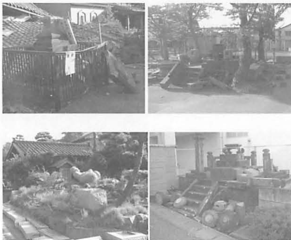
図30 石造物の転倒被害(柏崎市、刈羽村)
