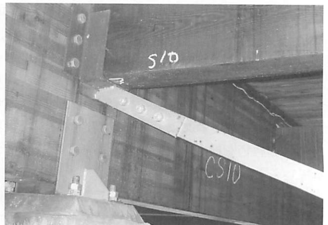
写真2 梁の取り付け部分
