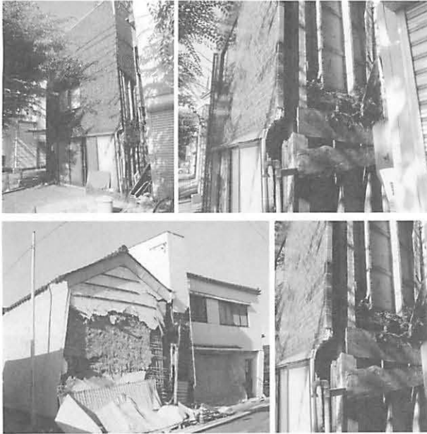
図15 店舗の隅角部の褐色腐朽とシロアリの食害痕（柏崎市）
