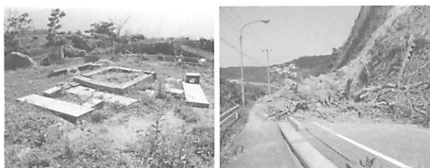
図27 コンクリートベンチ座板の飛躍、斜面崩壊による道路寸断（震源付近の灯台）
