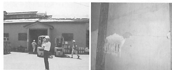
図18 補強により被害軽微な店舗（柏崎市）
