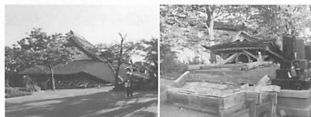
ア) 本堂の倒壊 イ) 鐘楼堂の倒壊
