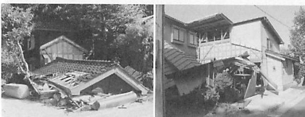
図13 下屋部分の倒壊（西山町、刈羽村）
