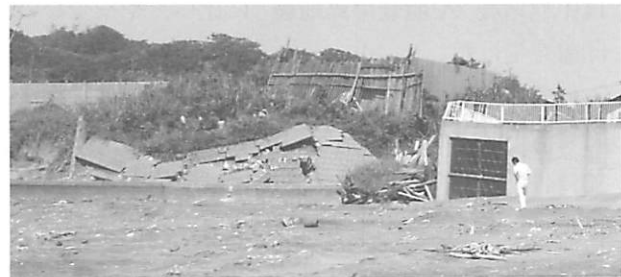
図28 アスファルト道の亀裂、砂地の亀裂、擁壁の崩壊、コンクリート構造物の沈下による曲げ破壊など（柏崎刈羽原発北辺の海岸）
