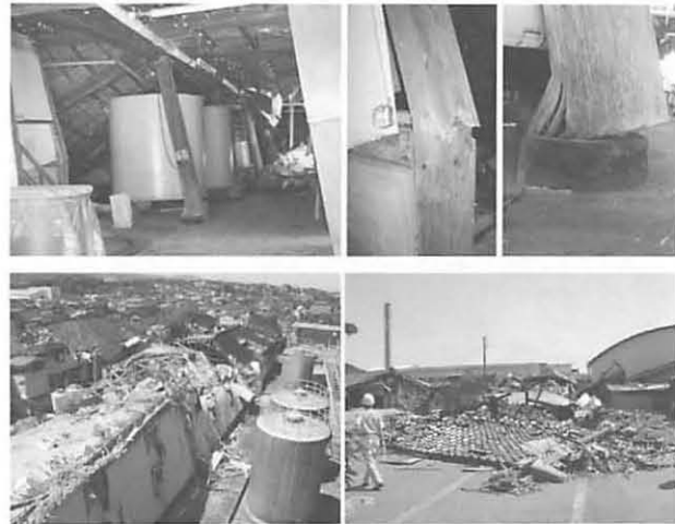
図7 酒造工場の伝統的な建築群の被害(柏崎市)
