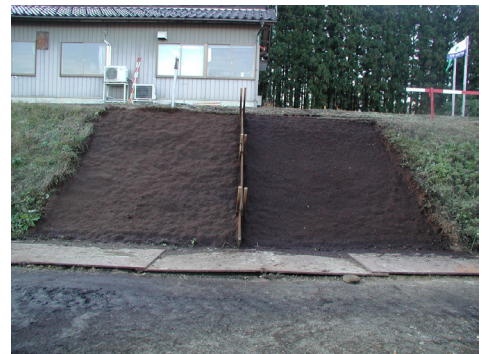
図1 吹付施工後の状況
