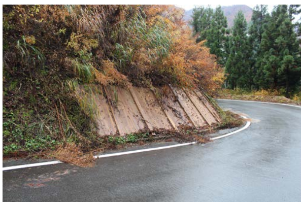
図3 施工後1年経過した防腐処理パネルの状況
