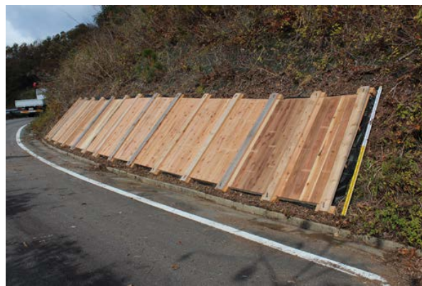
図2 防草シート、パネルの設置状況
