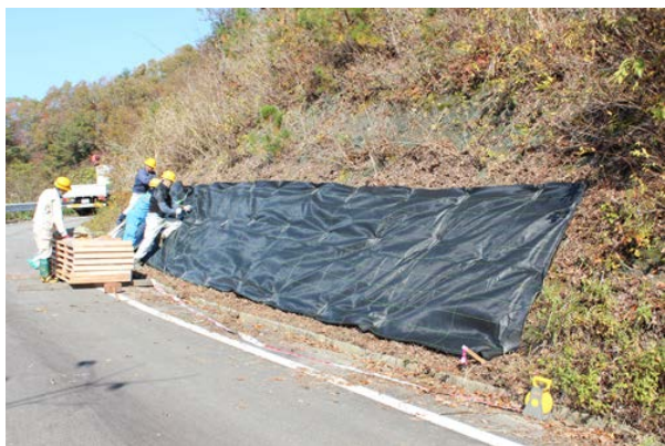
図2 防草シート、パネルの設置状況
