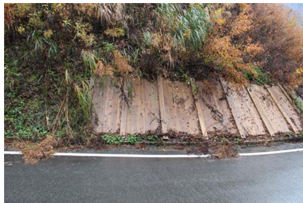
図3 施工後1年経過した防腐処理パネルの状況
