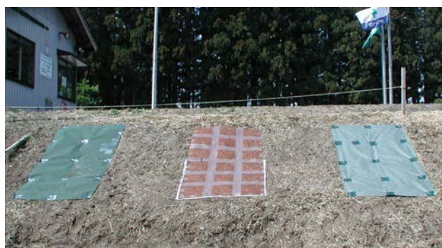
写真 3 スギ樹皮マットと市販防草シートの敷設状況
