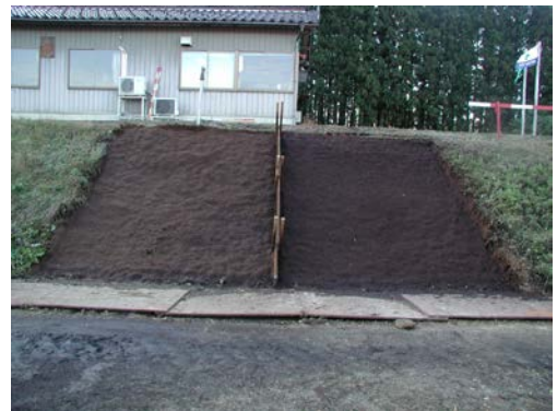
写真1 吹付施工後の状況 （右：スギ野積樹皮、左：スギ新鮮樹皮）
