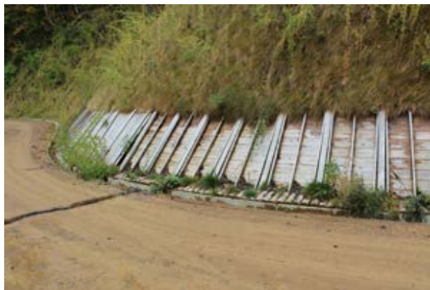
図4 施工後1年経過した法面パネルの状況
