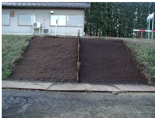
写真 1 吹付施工後の状況 （左：スギ新鮮樹皮、右：スギ野積樹皮）
