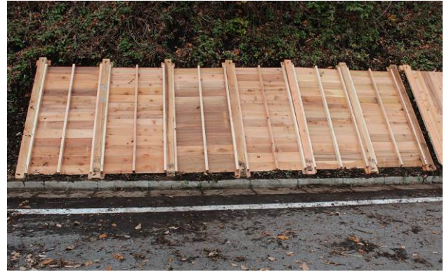
写真2 B型パネルの設置状況
