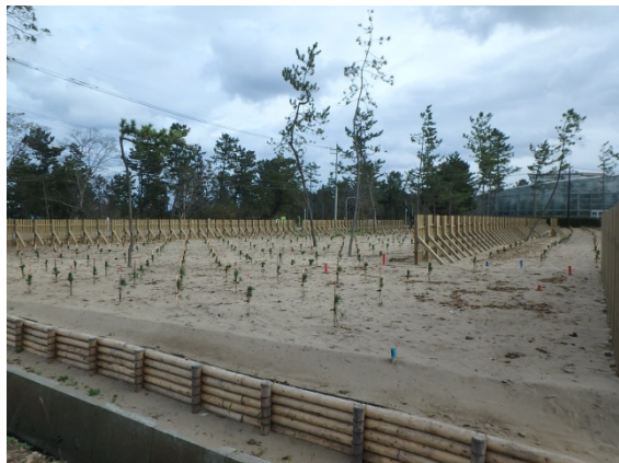
写真 1 施工地の状況
