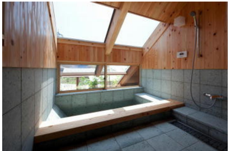
写真1. 木部を塗装した浴室内部 (H23年8月)
