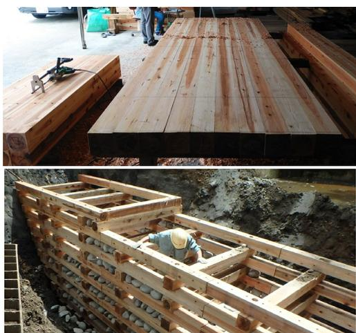
写真 1 部材加工状況 (上) と組立て状況 (下)
