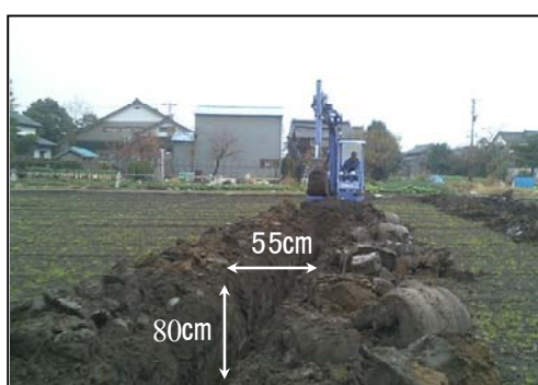
図1 難透水層の破碎処理方法
