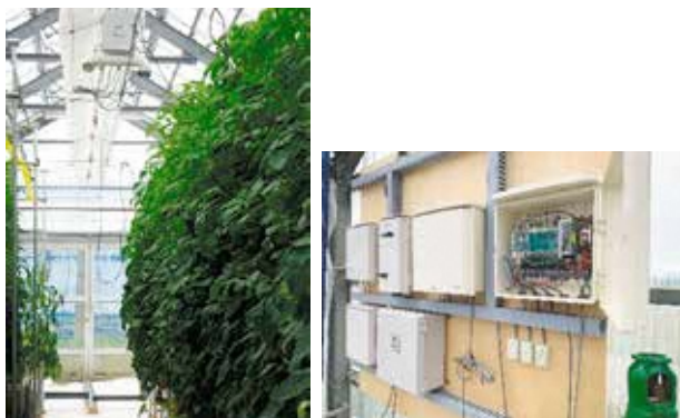
DIY環境制御によるトマト栽培 (左：内気象ノード、右：制御ノード)
