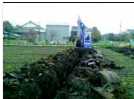
バックホーによる鋤床層の破碎
