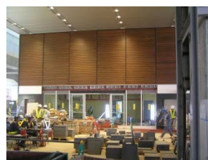
富山駅コンコース壁面
